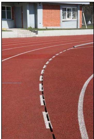
1.attēls. ACO Sport lietus uztveršanas kanāls. Tuvplānā bez pārseguma.
