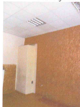
8.attēls. Kabinets 1.stāvā (telpa Nr.4)
