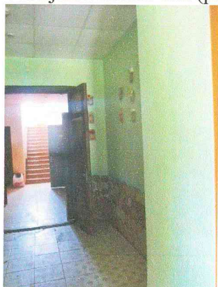
7.attēls. Priekštelpa un gaitenis 1.stāvā
