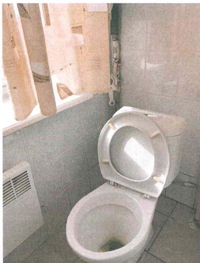
Savienotā sanitārtehniskā telpa_5
