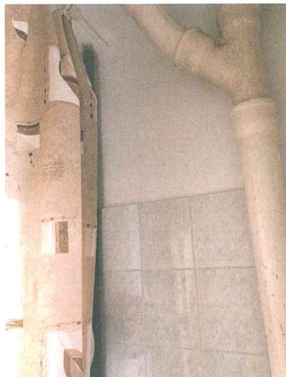
Savienotā sanitārtehniskā telpa_5
