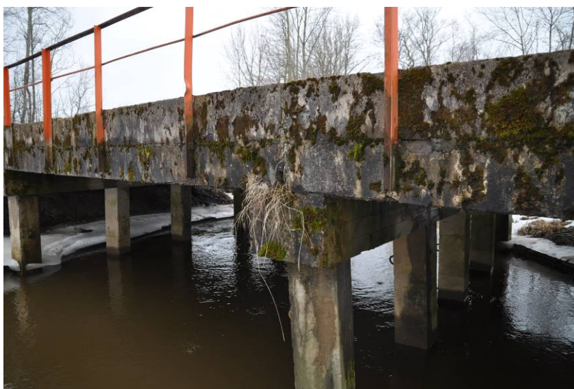
2.8.att. Bojāts uzkalas betons. Stiprinājumu zonā margu konstrukcija korodēt.
