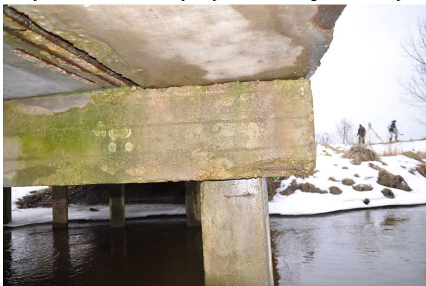
2.9 att. Pāļa un uzkalas betona un stieģrojuma korozija
