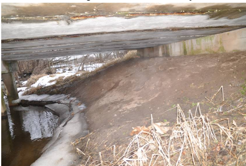
2.5 att. Izskalots konusa nostiprinājums (pie starpbalstiem)
