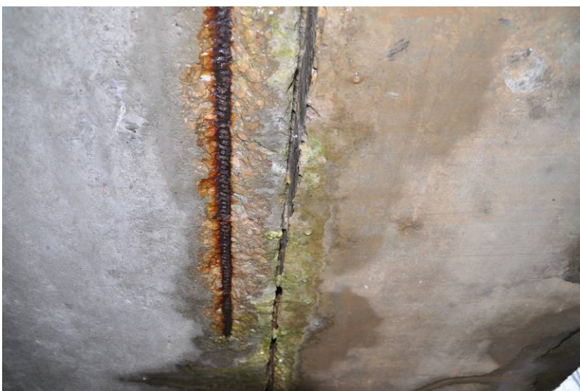
2.6 att. Ūdens caursūkšanās plātņu sadurvietās, plātņu stiegtrojumā korozija, betona aizsargkārtas atslāņošanās.
