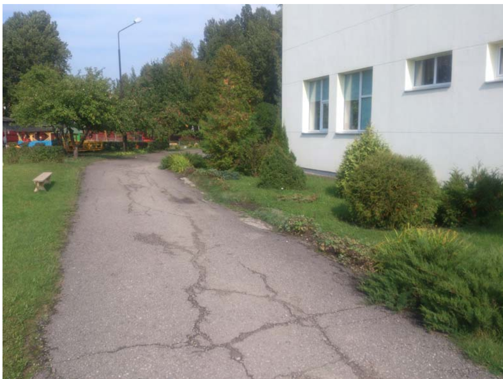
2.attēls: PII ēkas rietumu puse. Attēlā pa labi redzami košumkrūmi uz būvniecības laiku izvietojami pagaidu dobēs, pēc tam stādāmi iepriekšējā novietnē.
