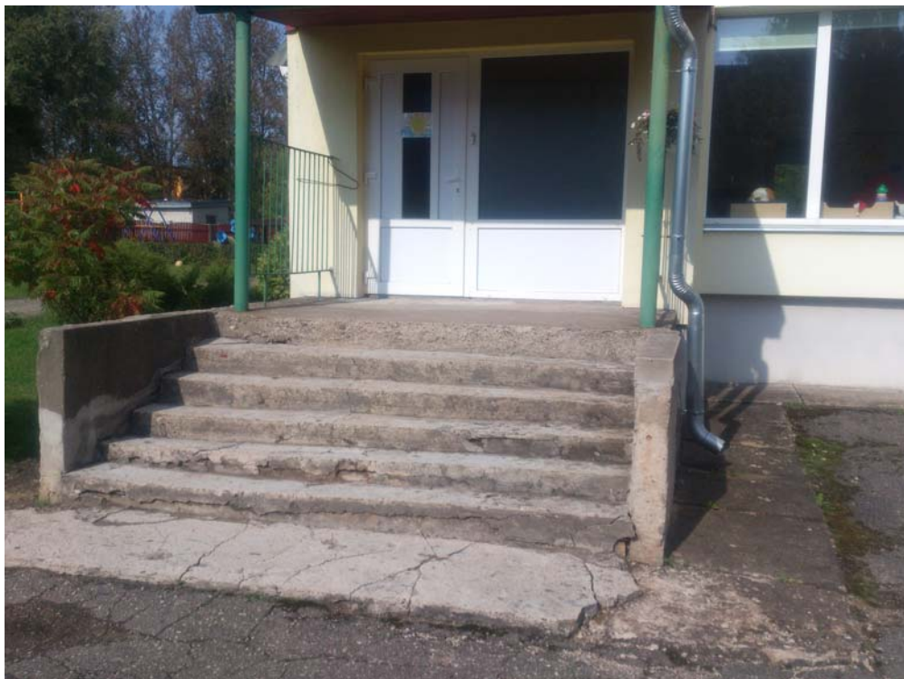
3.attēls: Pārbūvējamā kāpņu konstrukcija ēkas dienvidu ieejai.
