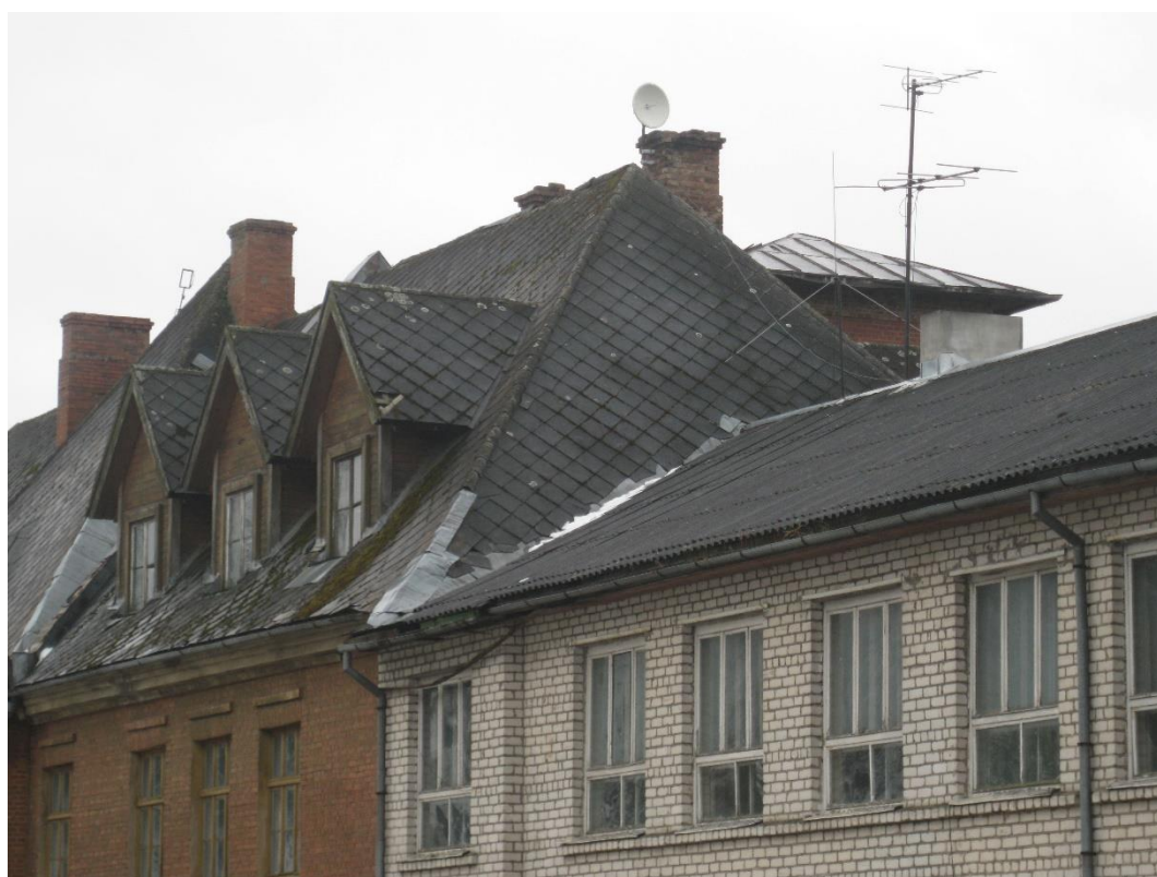
4. attēls. Ēkas stūris 8G, redzams bojāts jumta segums
