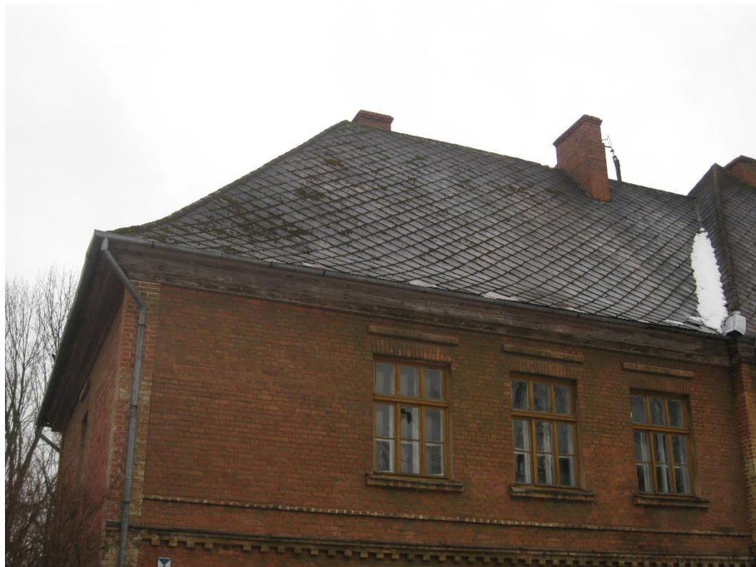
2. attēls. Jumts fasādē 1-2, redzams gludo azbestcements plāksnīšu jumta segums
