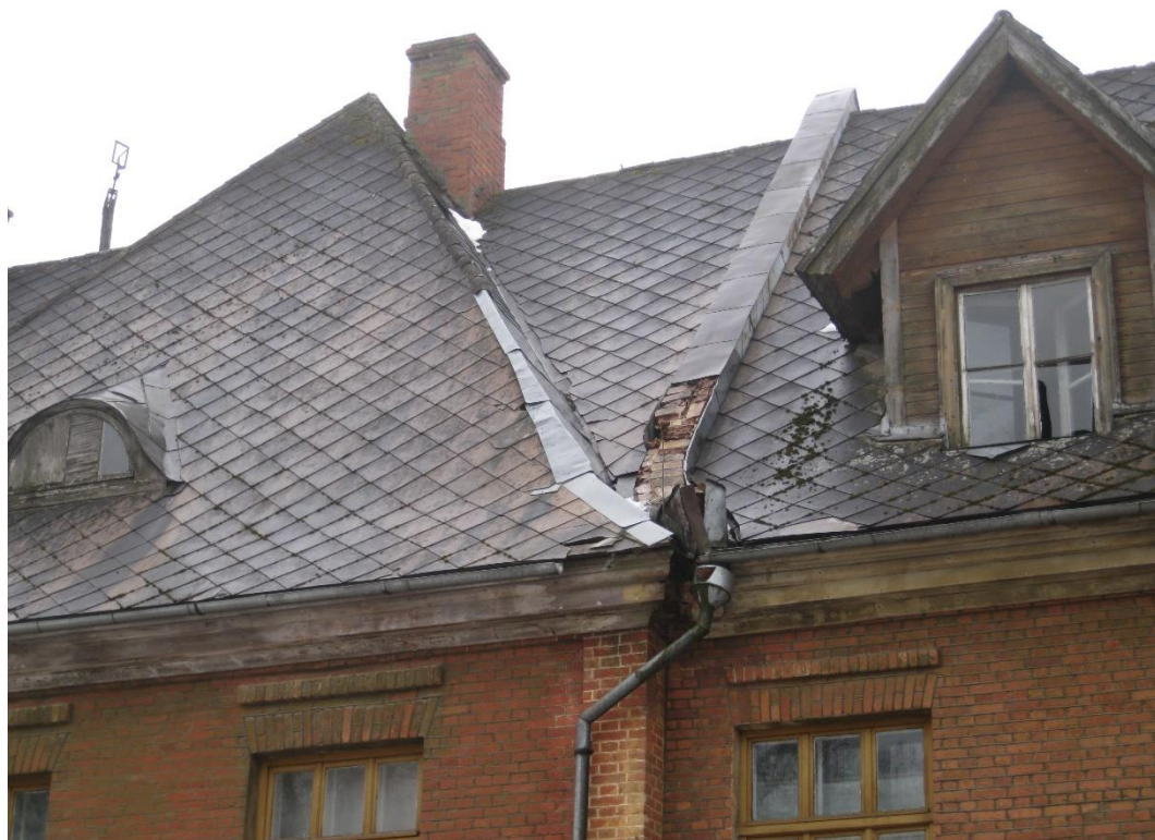
3. attēls. Jumts fasādē 2-3, redzams bojāts jumta segums un azbestcimenta plāksnīšu jumta segums
