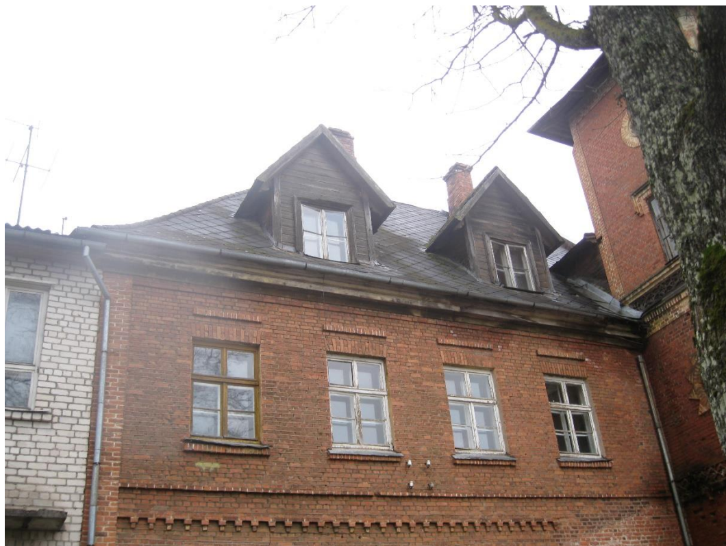
7. attēls. Jumts fasādē 8-6, redzamas 2 jumta izbūves, koka dzega un azbestcimenta plāksnīšu jumta segums
