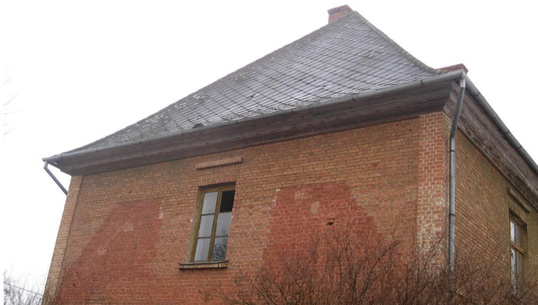
1. attēls. Jumts fasādē E-G, redzams gludo azbestcements plāksnīšu jumta segums
