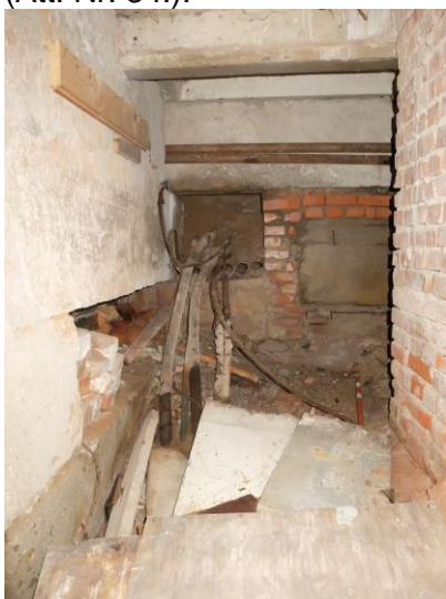
(Att. Nr. 36. Elektrības ievads ēkā, Atlauta jauda 100A, pagrabstāvs, A daļa).
