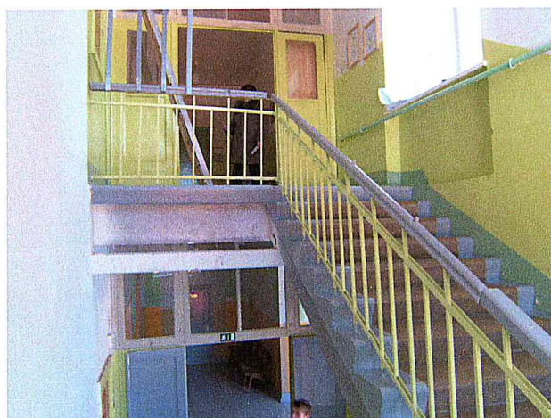
9. Saliekamās dzelzsbetona kāpnes ar pastiprinātiem laidiem un laukumiem.
