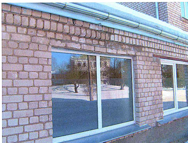
8. Deformējusies loga pārsedze piebūvei.
