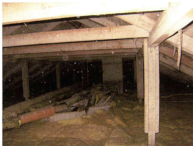
16. Bēniņi ar nepietiekamo pārseguma siltinājumu.
