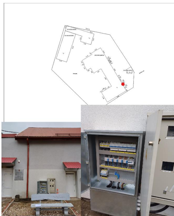
11. att. Dīķa iela 1 elektrosadale, uzskaitē
