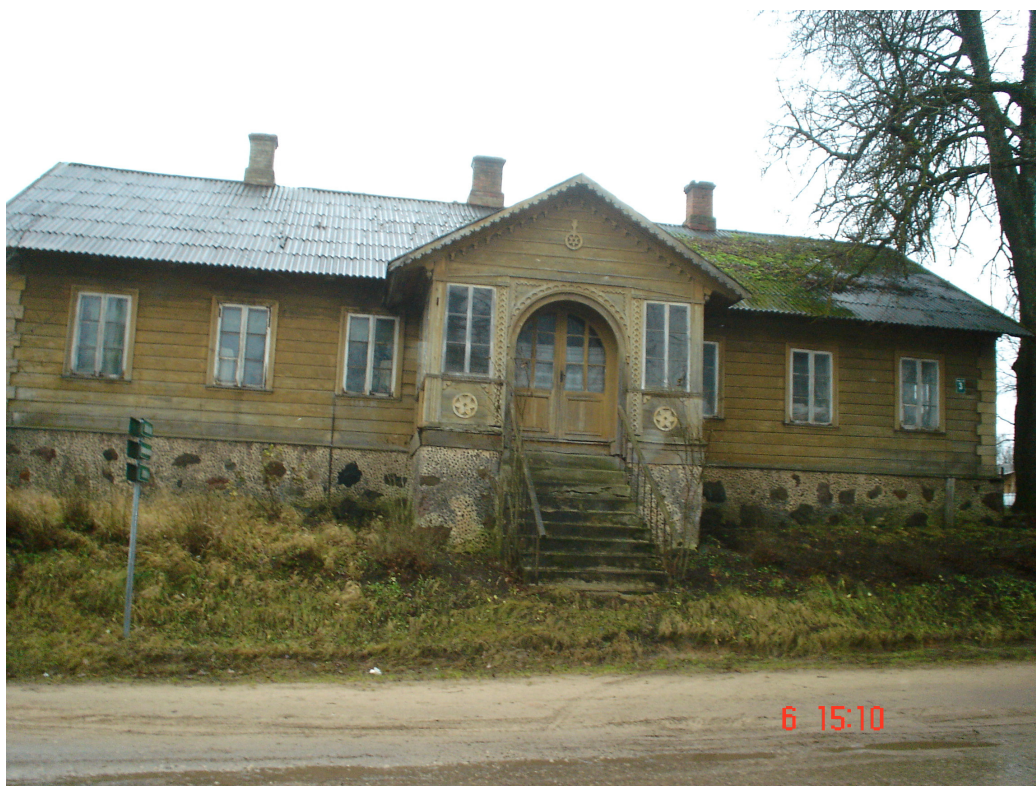
Dzīvojamā ēka Rīgas ielā 3
