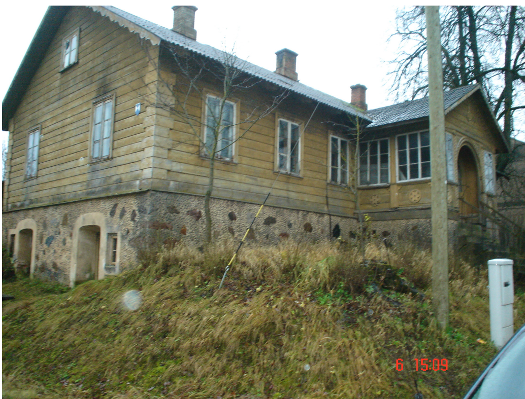
Dzīvojamā ēka Rīgas ielā 3
