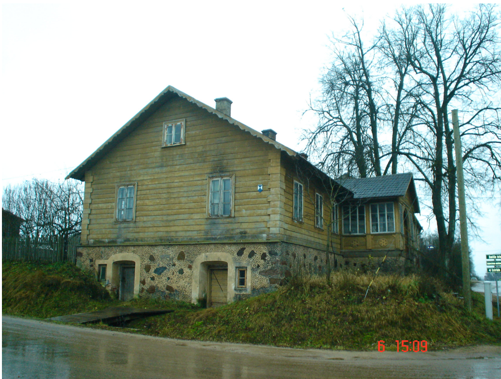
Dzīvojamā ēka Rīgas ielā 3
