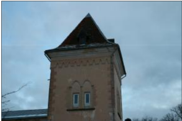
Dzegas mezgla atjaunošana. Nokalt dzegas apmetumu ap plaisas vietām, lai konstatētu, vai plaisas iet pa mūra šuves vietu vai arī pa ķieģeļiem. Ja plaisa iet pa mūra šuves vietu, nepieciešam mūra injecēšana, ja pakieģeļiem, dzega jāpārmūrē.
