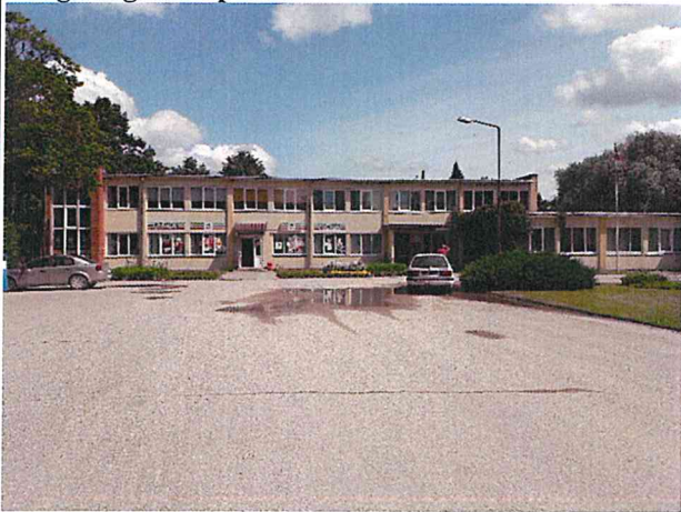
Asfalta segums ap ēku, funkcionē kā piebraucamais ceļš un auto novietnes zona. Ceļu un celiņu iesegums vērtējams, kā labā stāvoklī.
