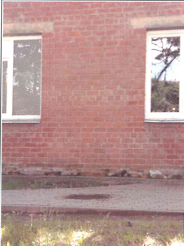
Ķieģeļu pamati, vietām ārējais apmetums ap cokolu ir nodrupis un bojāts
