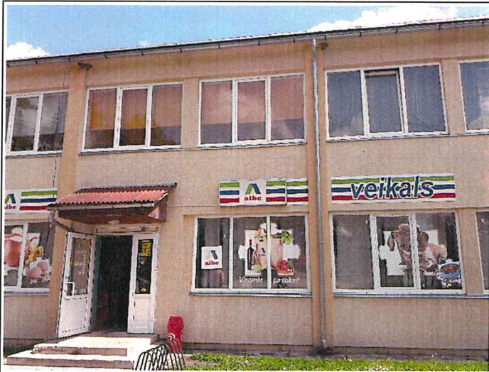
Bez iepriekšējas saskaņošanas tika veikts telpu pārplānojums, nesošajās konstrukcijās, tajās izveidojot ailes
