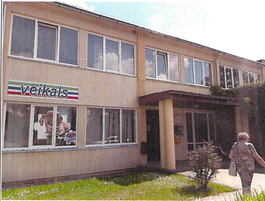
Pie ieejas Pastā izveidots koka konstrukcijas jumtiņš, kas balstās uz ķieģeļu mūrējuma stabiem, apmesti, krāsoti. Virs koka konstrukcijas izvietots šifera pārklājums, kā arī tekne lietus ūdens savākšanai. Jumta konstrukcija apmierinošā tehniskā stāvoklī. Nepieciešams nomainīt šifera loksnes.
