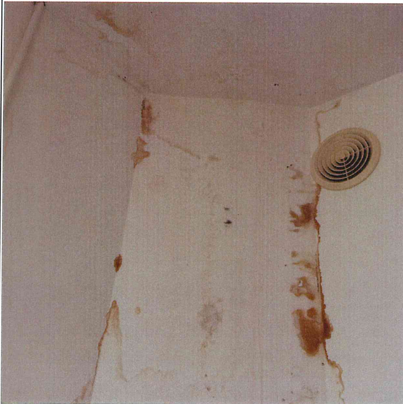
Sanmezglā apšūts stāvvads, kas ir bojāts un cauri sūcas mitrums. Līdz ar to, mitruma rezultātā, uz sienas radusies sēne
