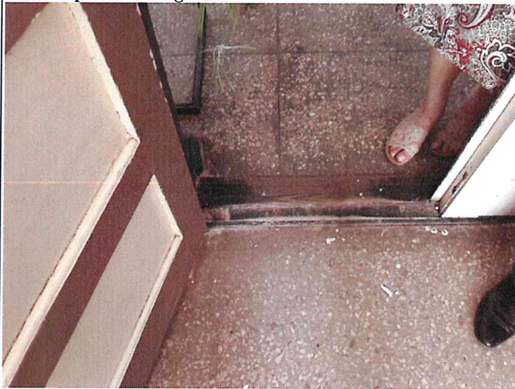
Vērojami arī slīpēta betona grīdas segumi
