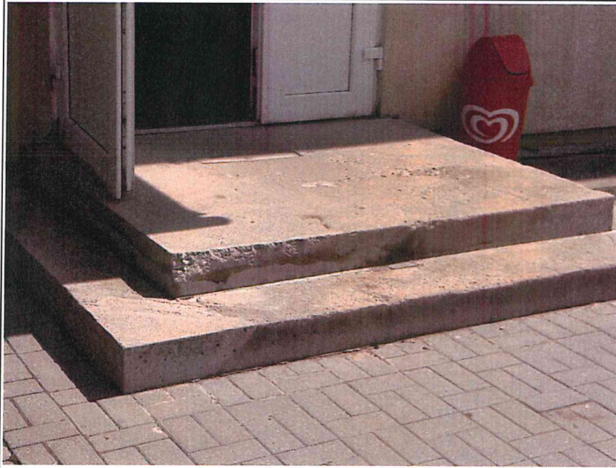
Pie veikala ieejas veidots betona lievenis ar pakāpieniem, kas ir daļēji apmierinošā stāvoklī, daļēji segums atslāņojies.
