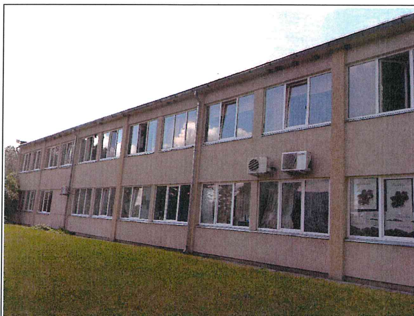
Savietotais jumts ar iesegumu. Jumta seguma rekonstrukcija veikta 2010. gadā. Labā stāvoklī.
