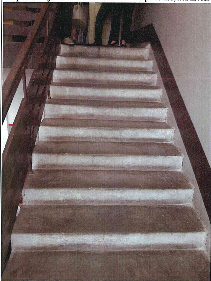
Betona kāpnes ar koka/metāla konstrukcijas margām. Labā stāvoklī.
