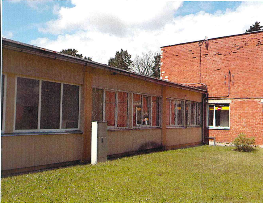
Ēka veidota no ķieģeļu mūra. Aptuveni puse no ēkas kopējās fasādes ir atstāta kaila, bet otra puse ir apmesta
