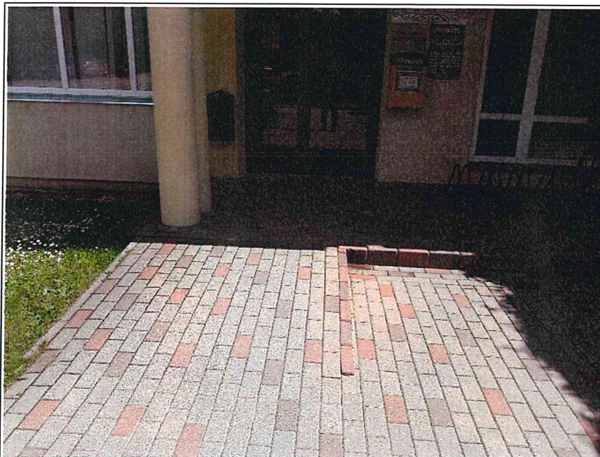
Pie pasta ieejas durvīm izveidots neliels panduss, atbilstoši vides pieejamības prasībām
